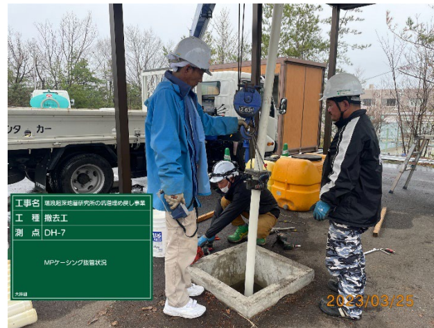
ケーシング切断・引き抜き
