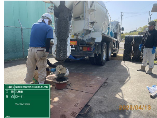
モルタル打設
