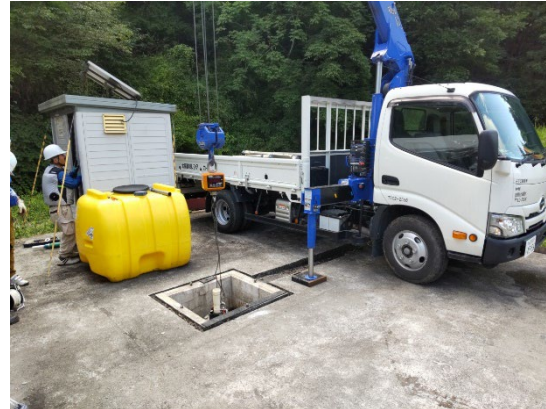
ケーシング引き抜き
